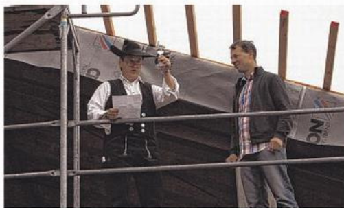
Generalbauunternehmer Thorsten Knebusch kam in Zimmermannskluft und verlas in luftiger Höhe den Richtspruch.
